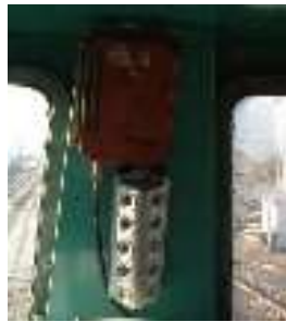
Установка блока индикации в кабине
