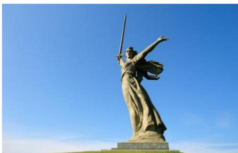
Сложнейшее строительство шло в период с 1959 по 1967 год. Для изготовления памятника понадобилось 5,5 тысячи тонн бетона и 2,4 тысячи тонн металлических конструкций. Внутри «Родина-мать» абсолютно полая, она состоит из отдельных камер-ячеек, в которых натянуты металлические тросы, поддерживающие каркас памятника. Высота грандиозного монумента — 85 метров, он занесен в
