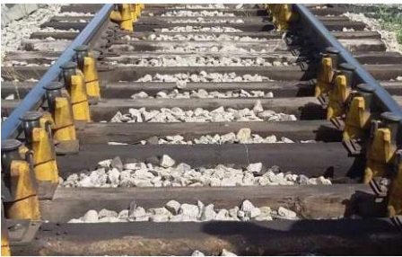
Рисунок 5 - Расположение стопперов на приемоотправочных путях станции.
