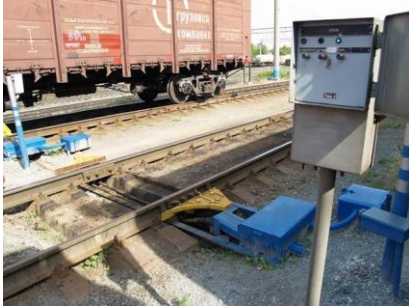
Рисунок 4 - Расположение колонки местного управления упором.
