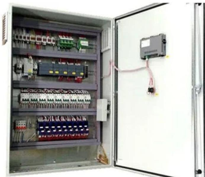
Рис.1. Шкаф контролируемого пункта КП.
