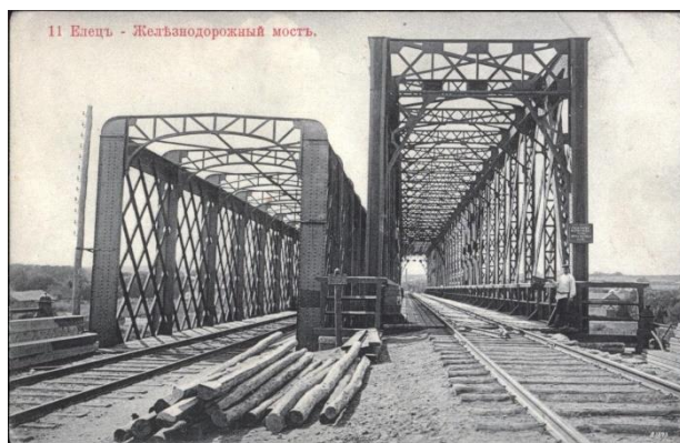
Рис. 2 Строительство «Чугунного» железнодорожного моста через р. Быстрая Сосна
