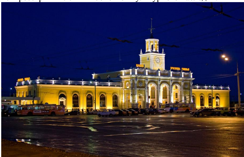
Рисунок 2. Здание вокзала Ярославль-Главный.
