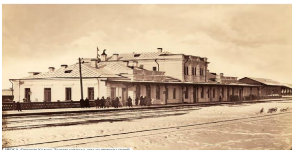
Рисунок 1. Станция Калуга. Здание вокзала
