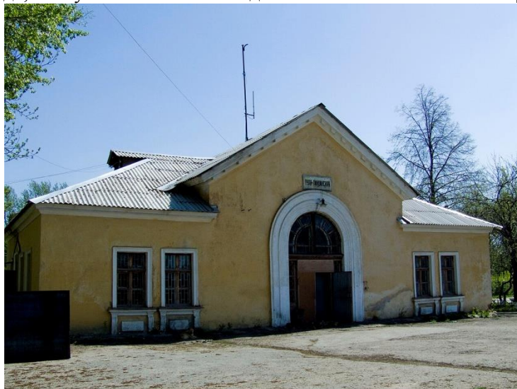
Фотография 2. Здание станции Тула-Лихвинская.
