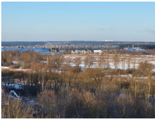
Рис.1. Железнодорожный мост через реку Ока
